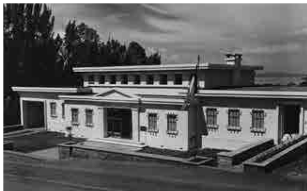
Immeuble de la Banque congolaise à Bukavu. Le plan avait été réalisé par la Société immobilière du Kivu (SIMAK). (HP.1956.15.13724, collection MRAC ; photo C. Lamote (Inforcongo), s.d., © MRAC.)
