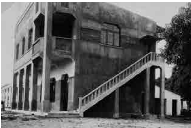
À Uvira, le 24 février 1932, le bâtiment Rovnitzky en construction sur la parcelle 24bis. (HP.1986.48.4-103, collection MRAC ; photographie non identifiée, droits réservés.)
