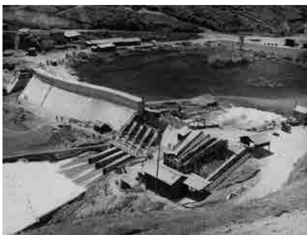
Une vue d'ensemble du chantier de la centrale hydro-électrique de la Ruzizi (mai 1958). La centrale, actuellement achevée, distribue le courant électrique à une bonne partie du Kivu (Bukavu-Cimenterie de Katana) et à Usumbura jusqu'où a été tirée une ligne à haute tension à travers la plaine de la Ruzizi. (2018.5.27-47, collection MRAC ; photo P. Laval (Inforcongo), © MRAC/Laval.)
