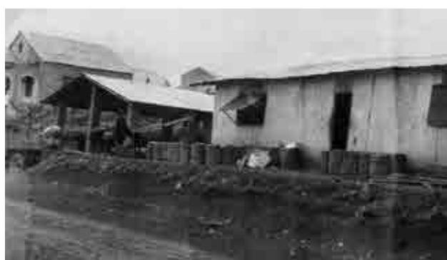
Garage et habitation des agents de la SIMAK (décembre 1929). (HP.1986.48.4-3, collection MRAC ; photographe non identifié, droits réservés.)
