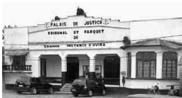
Bâtiment du parquet de Grande Instance à Uvira. (Photo Théodore Assumani, équipe locale ; 2021.)
