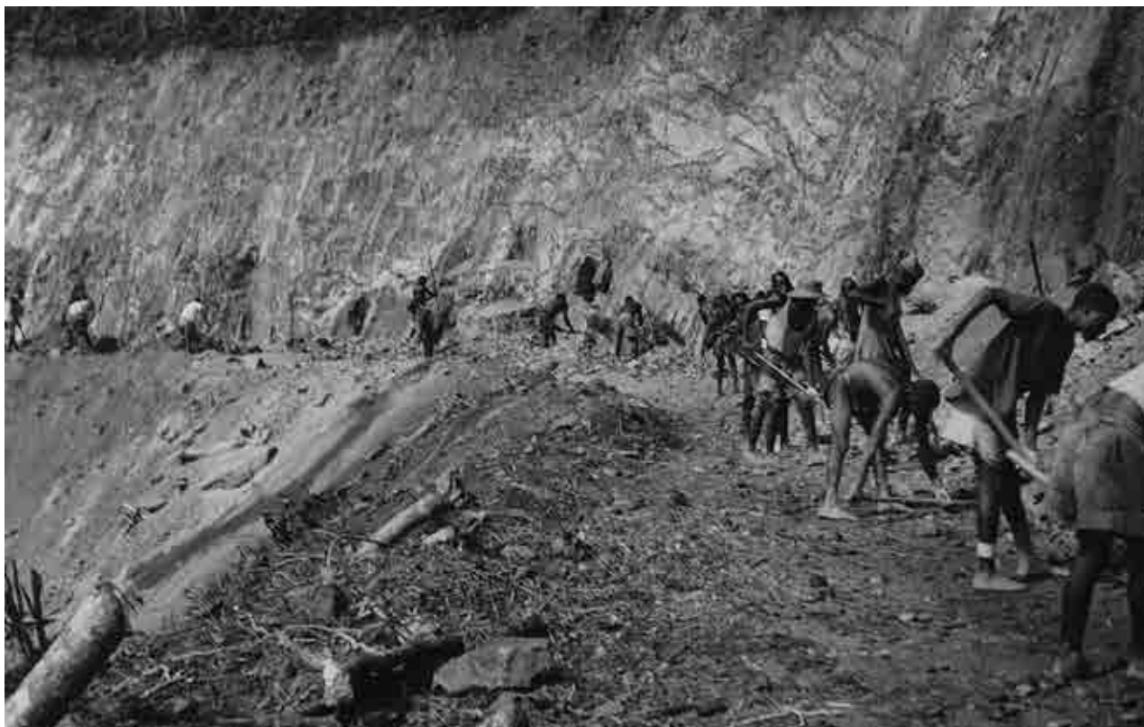
Travaux routiers dans l'escarpement de Kimbili (route de Bukavu à Shabunda), 1949. (HP.1956.15.16264, collection MRAC ; photo F. De Pooter (Inforcongo), © MRAC/De Pooter.)
