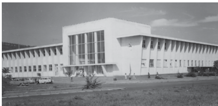
Le nouveau bâtiment de la poste à Bukavu. (HP.1959.28.798, collection MRAC ; photo C. Lamote (Inforcongo), s.d., © MRAC.)
