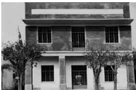
À Uvira, le bâtiment CPHACO en voie d'achèvement. (HP.1986.48.4-49, collection MRAC ; photographe non identifié, s.d., droits réservés.)
