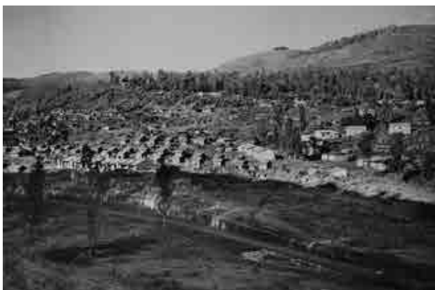
Érection à Costermansville d'un quartier pour Congolais avec des maisons en matériaux durables financées par un fonds d'avances créé par le gouvernement. (HP.1956.15.3389, collection MRAC ; photo C. Eeman (Inforcongo), 1948, © MRAC/Eeman.)
