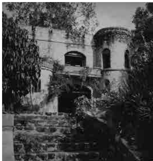
Le château de Xavier Dierickx à Nyalukemba : la construction ne fut achevée qu'en 1930.
