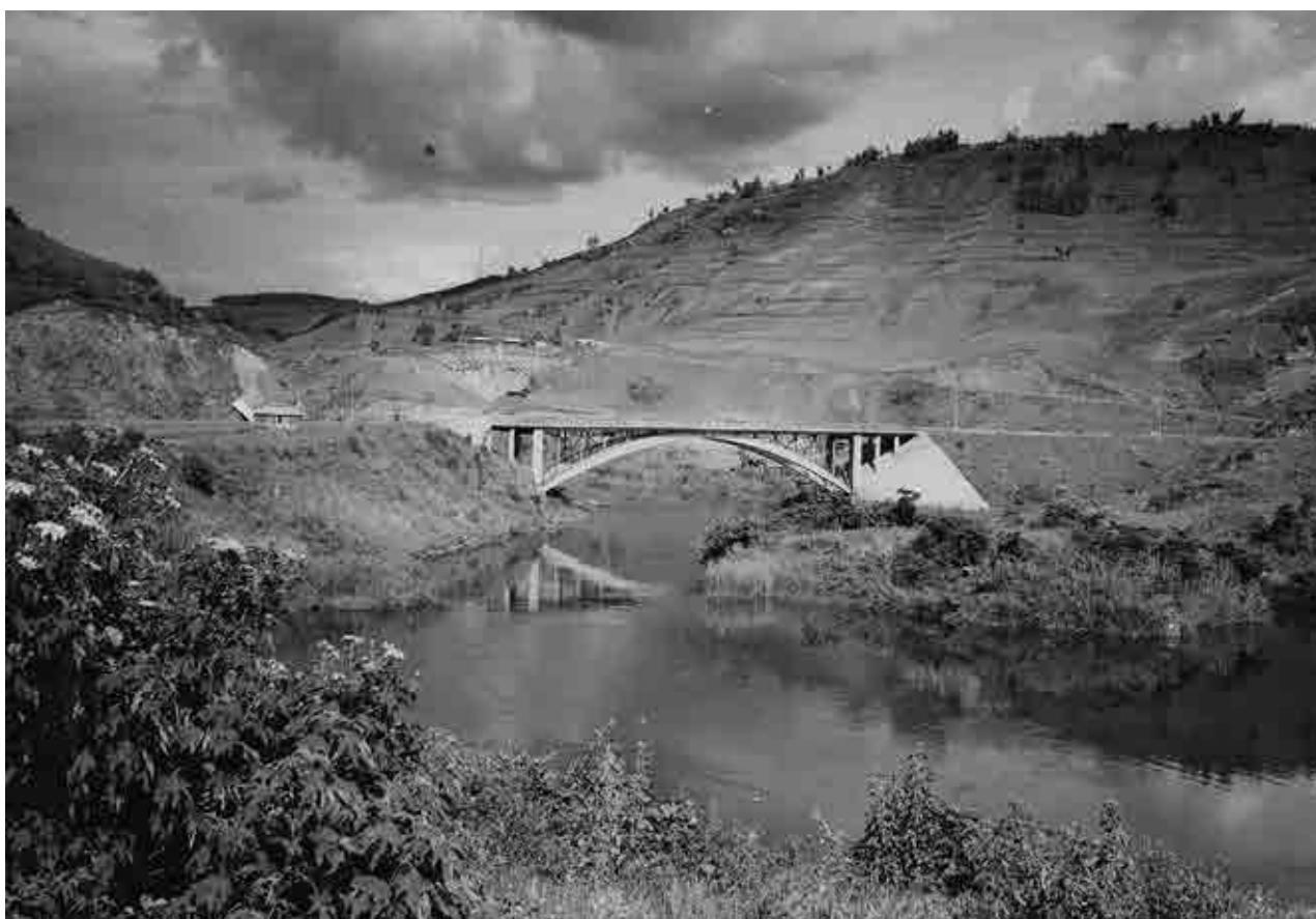
Le pont de la Ruzizi à la sortie de Bukavu, sur la route qui relie le chef-lieu de la province du Kivu à Usumbura. (HP.1959.28.779, collection MRAC ; photo C. Lamote (Inforcongo), s.d., © MRAC.)
