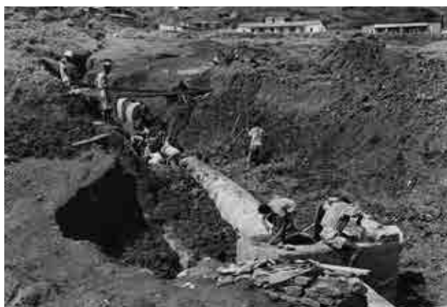
Travaux de canalisation de la Funu lors de l'établissement des égouts au centre extra-coutumier à Costermansville. (HP.1956.15.10236, collection MRAC ; photo C. Lamote (Inforcongo), s.d., © MRAC.)
