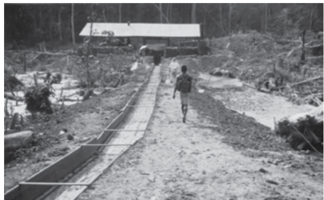
Station de pompage de Kailo en novembre 1936. (HP.1980.51.4-33, collection MRAC ; photographe non identifié, droits réservés.)
