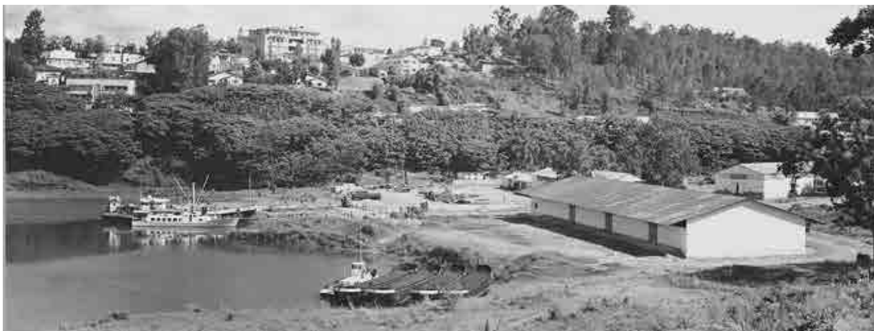
Les installations du port à Bukavu, sur le lac Kivu. (HP.1959.28.788, collection MRAC ; photo C. Lamote (Inforcongo), s.d., © MRAC.)
