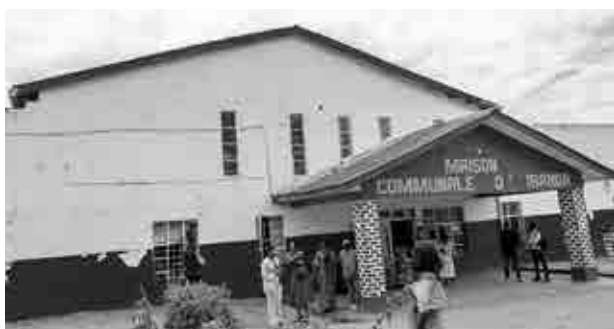
Bâtiment administratif de la commune d'Ibanga à Bukavu. (Photo reçue d'Aymar Nyenyezi Bisoka, 17 janvier 2023.)
