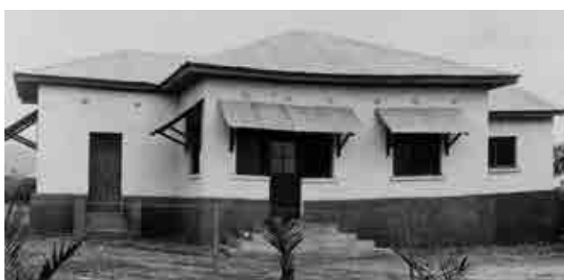
À Uvira, le 15 janvier 1932, la maison de la parcelle 20. (HP.1986.48.4-101, collection MRAC ; photographe non identifié, droits réservés.)
