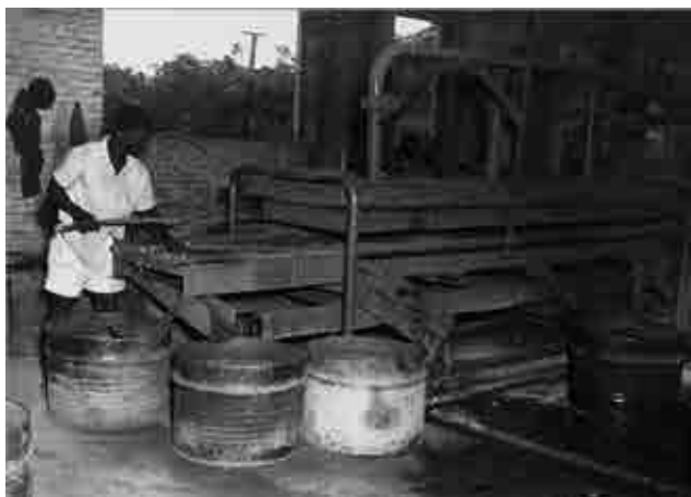
À l'usine de traitement se trouve un séchoir infrarouge à travers lequel le minerai d'étain passe après le lavage.
